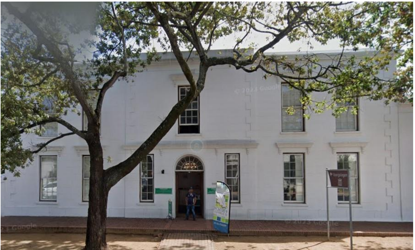
Voorgelegen building external façade at Dorp Street
