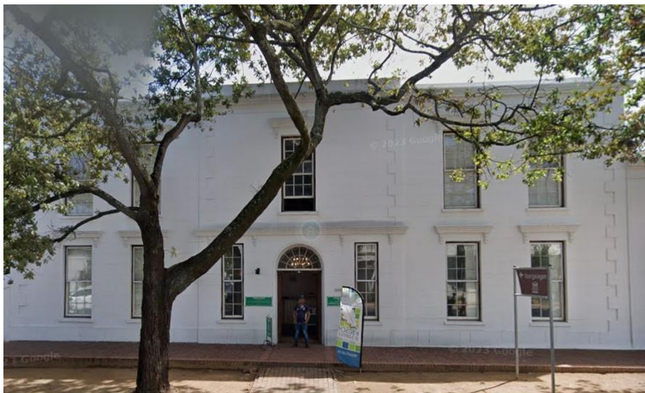
Voorgelegen building external façade at Dorp Street
