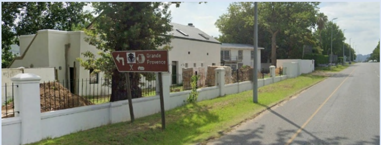
Existing werf wall elements
