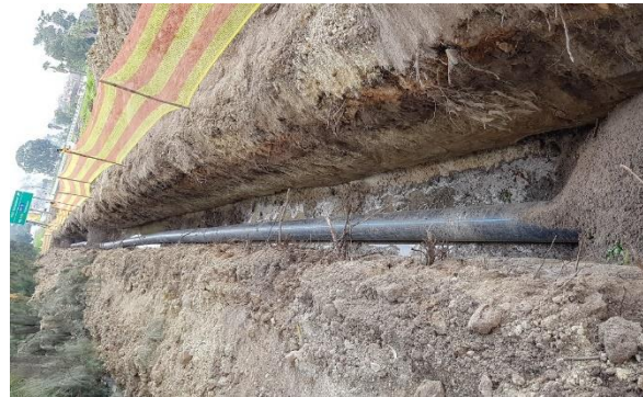
Figure 45: Koelenhof Bulk Water Project (Devonbosch)
