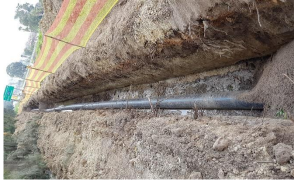
Figure 45: Koelenhof Bulk Water Project (Devonbosch)
