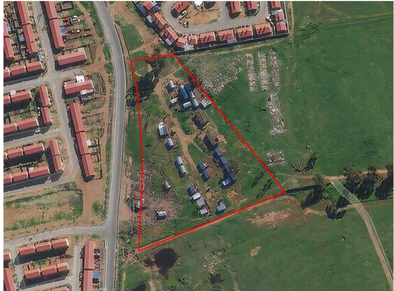
Figure 33: Erf 2183, La Rochelle, Klapmuts
