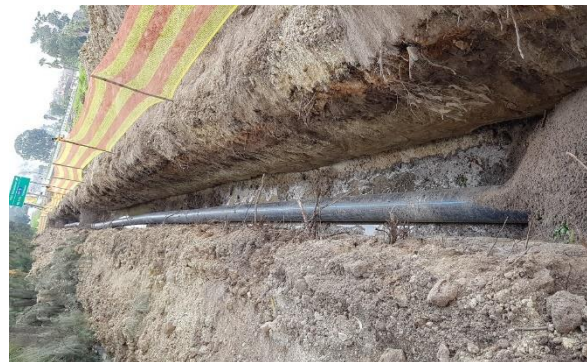
Figure 45: Koelenhof Bulk Water Project (Devonbosch)
